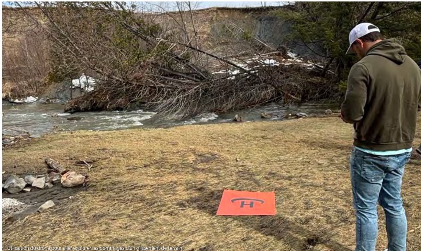
Utilisation du drone pour aller explorer les dommages d'un glissement de terrain.
